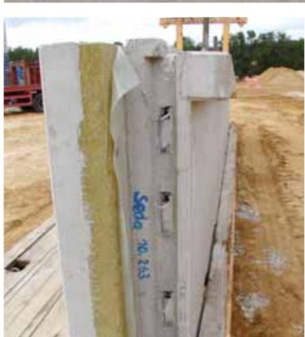
Mur préfabriqué avec Loop Box HLB sur le chantier
